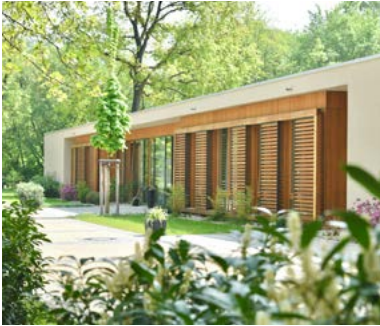
Das Hospiz Köpenick, Außenansicht. (Foto: Uwe Baumann)
